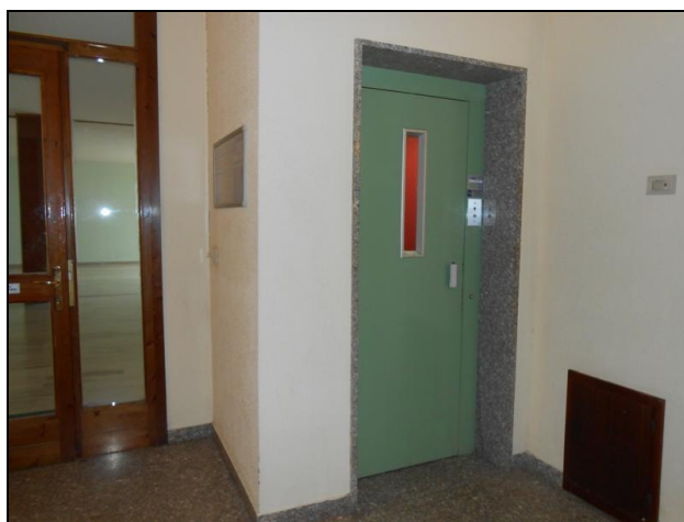
Ascensore vano scala B
