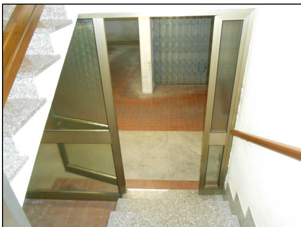
Accesso al piano seminterrato
