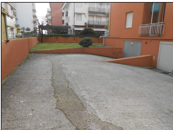
Spazio esterno e rampe di accesso
