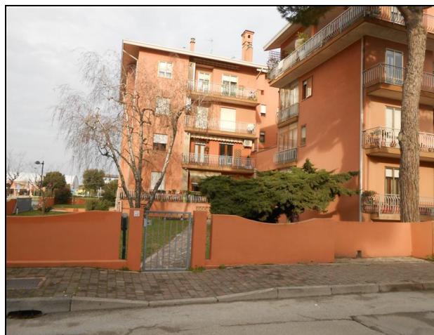
Ingresso in Viale Falconera n. 53
